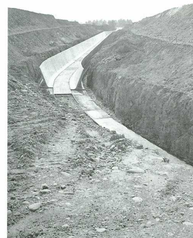
Revestiment 1r. tram del Canal Auxiliar
