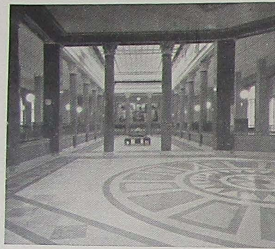
Patio de Operaciones
