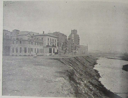
Aspecto actual de la zona afectada por la prolongación del muro, que permitirá su urbanización definitiva.
