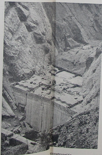
Presa de Escalades en construcción
