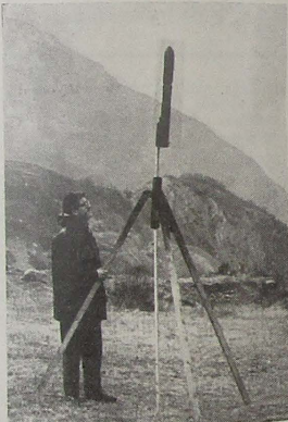
Un tripode de acero sirve de guía al cohete en el instante del lanzamiento
