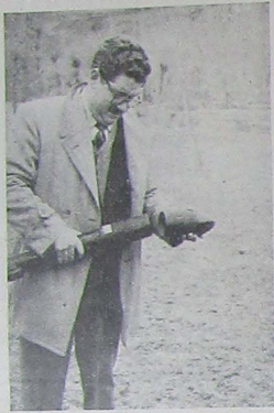
La caperuza del proyectil cargada del producto condensador, se acopla al cuerpo del cohete antes de ser lanzado.
