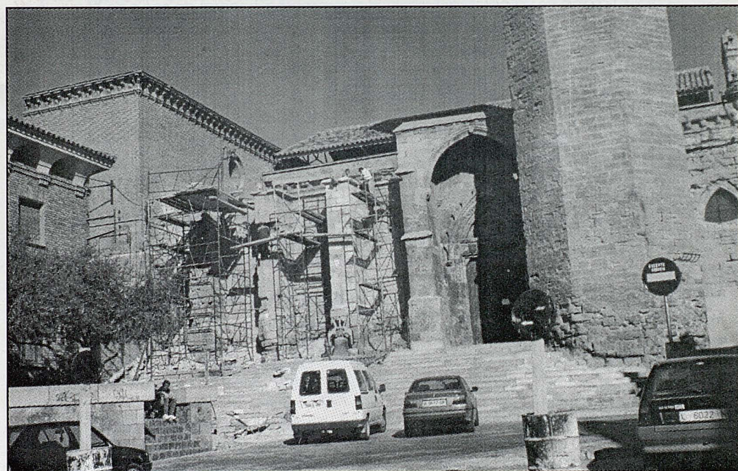
OBRES DE REPARACIÓ DE L'ESGLÉSIA DE SANT LLORENÇ
