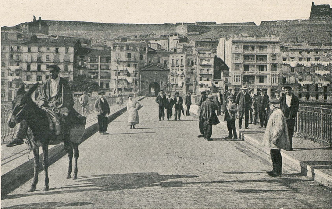
ENTRADA DEL PUENTE.
