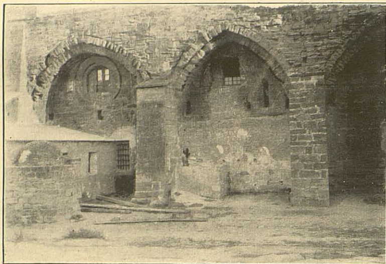
Arcades del pati interior de l'Açada menjades per l'addició de construccions auxiliars.
