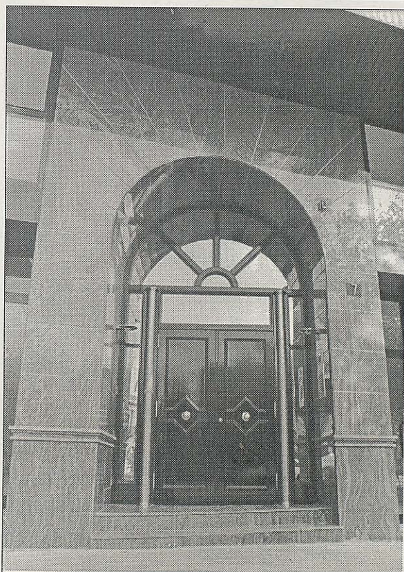
Edifici plaça les Missions,7 realitzat per Roig Construccions
