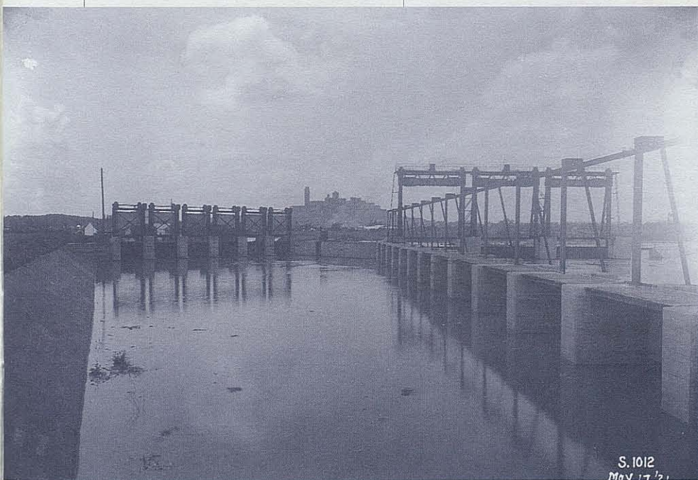
Construcció de les comportes del Canal de Seròs (1921).
