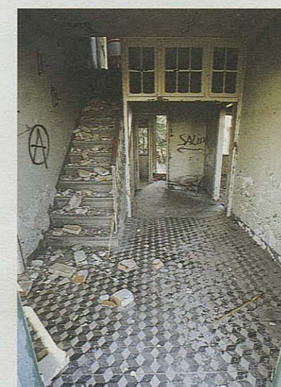
A la imatge de l'esquerra, es veu l'estat actual de les escales, un cop arrançades, però pendents encara de l'acabament de les obres. A dalt, les mateixes escales abans d'iniciar-se la rehabilitació de l'interior del xalet de la Canadencia.
