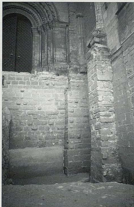
Fonamentació del mur de tancament sud de la Seu Vella, de la Capella de Recasens i d'un dels pilars de sustentació del pòrtic de la porta dels Fillols.
