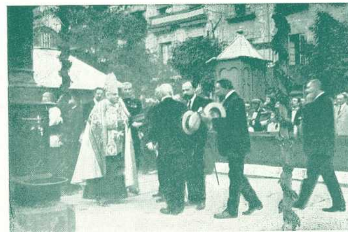
3 Julio 1921.—Una de las fechas de más grato recuerdo para Lérida, en cuyo día se efectuó la inauguración oficial de las obras del nuevo servicio de aguas potables, bendiciéndose por el Prelado de la diócesis una nueva fuente en la Plaza de la Constitución.—Fot. FARRÁN.
